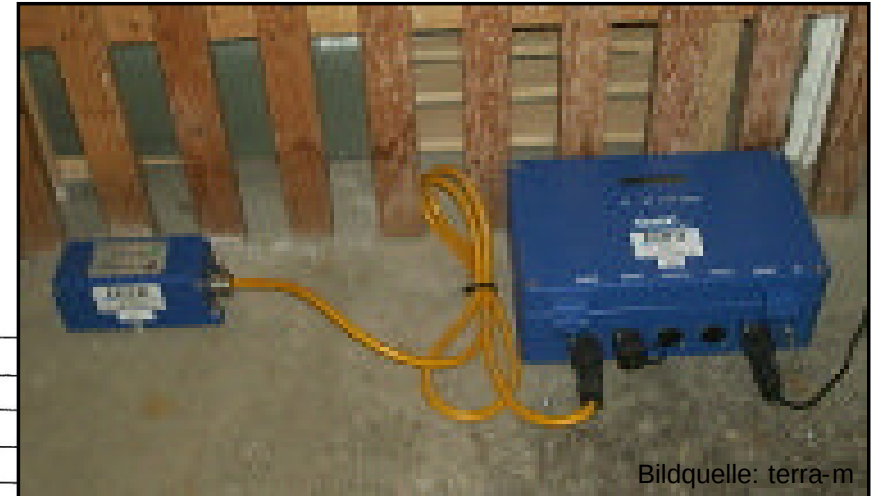
Erschütterungsmessung am Fundament: Dreikomponentensensor, Steuer- u. Aufzeichnungseinheit
