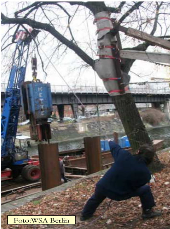
Abb.5a-d: Von den Baumkletterern angeseilte störende Äste werden bei der Einschwenkung sowie beim Einpressen bzw. Rammen der Spundbohlen zusätzlich vom Ufer aus weg gezogen.
