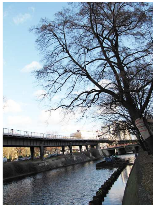
Abb.11: Trotz des ufernahen Spundwandbaus bleibt das durch Altbäume geprägte Landschaftsbild erhalten.
