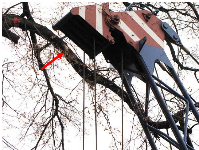
Abb.7: Vom Ausleger-Kopf beim Rammen tangierter Starkast mit Rindenverletzung; der Schaden entstand, weil der Ausleger beim Rammen in Vibration gerät und dadurch die Rinde von Ästen aufscheuern kann.
