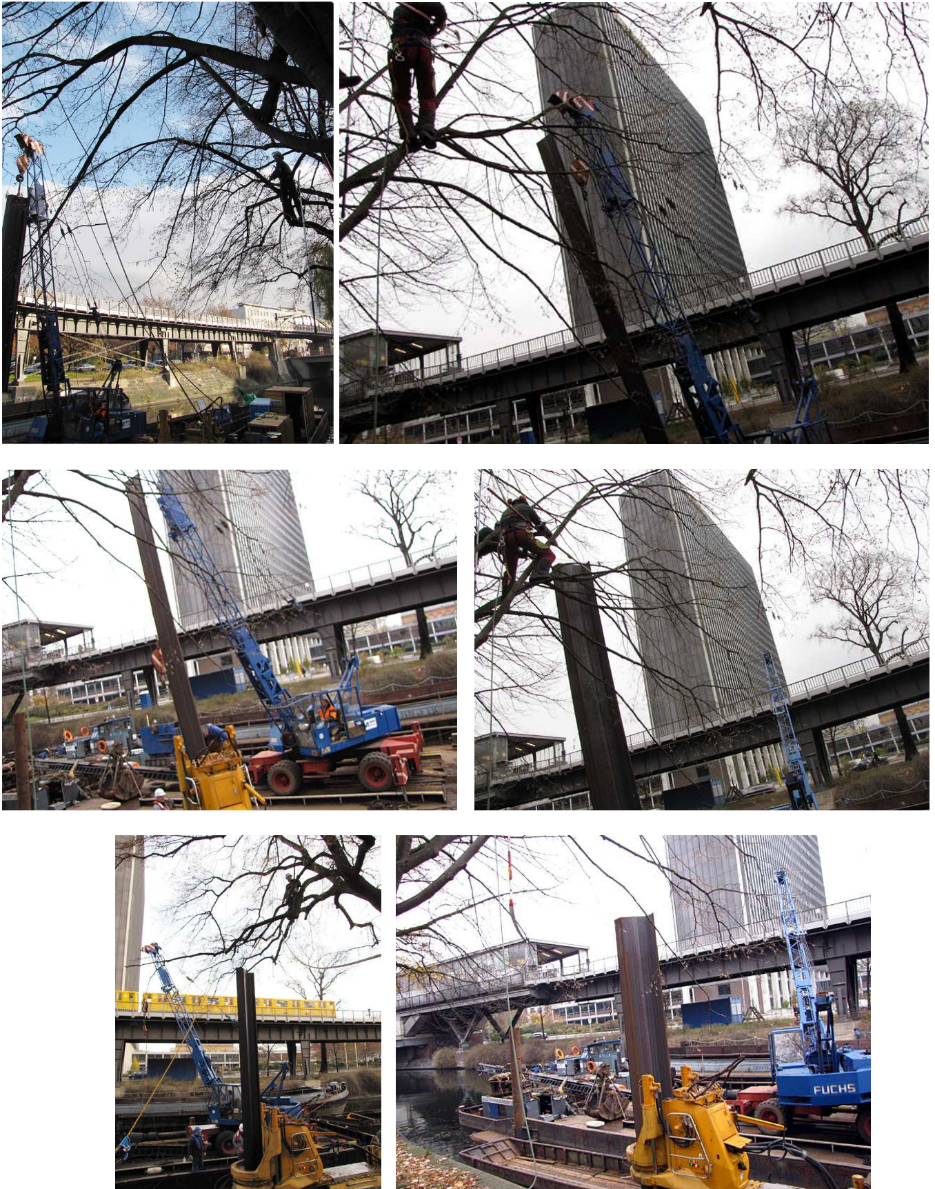
Abb.4a-f: Die Baumkletterer ziehen die störenden Äste bei der Einschwenkung und beim Einpressen der Spundbohlen aus dem Arbeitsfeld, ohne dass Äste oder Zweige zurück geschnitten werden müssen.
