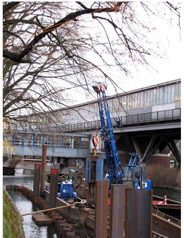
Abb.5a-d: Von den Baumkletterern angeseilte störende Äste werden bei der Einschwenkung sowie beim Einpressen bzw. Rammen der Spundbohlen zusätzlich vom Ufer aus weg gezogen.
