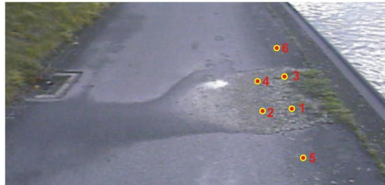
Beispiel aus der Detektion und anschließenden Verifikation von Hohlräumen an einer Kanalböschung
