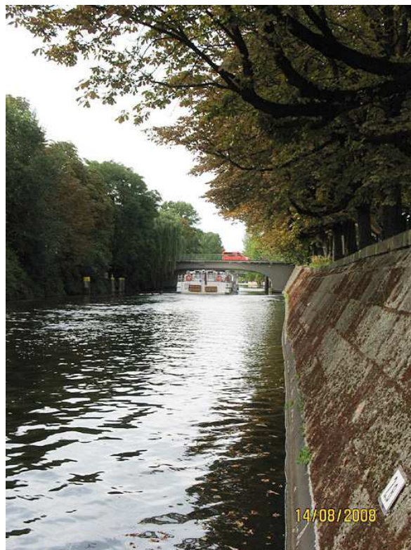
Abb.3: Zustand des Uferabschnitts nach Beendigung der Maßnahmen: hier sind nur geringe Rückschnitte und allerdings erneute Bindearbeiten während der geplanten Spundwandarbeiten erforderlich.
