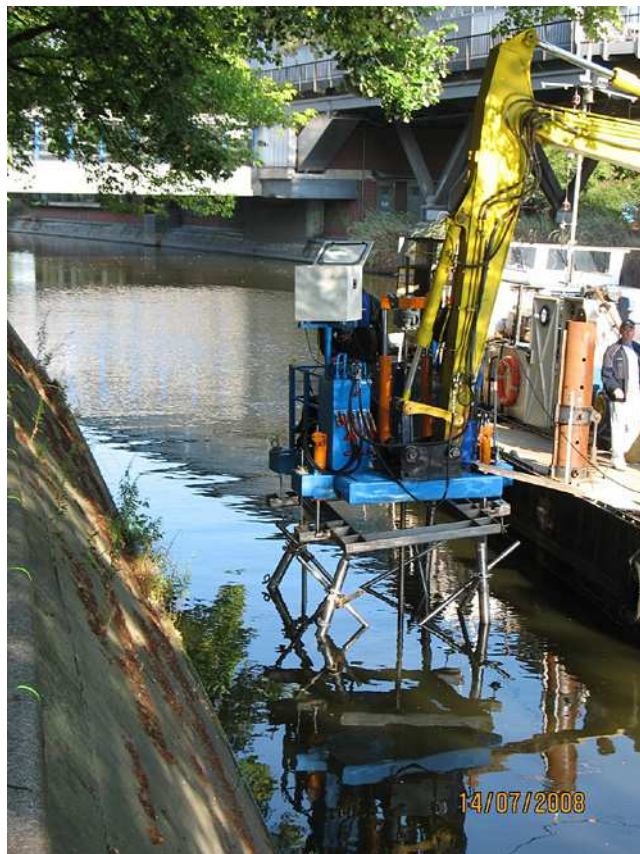
Abb.1: Arbeitsabstand und erforderliches Lichtraumprofil während der Kampfmittelsondierung.
