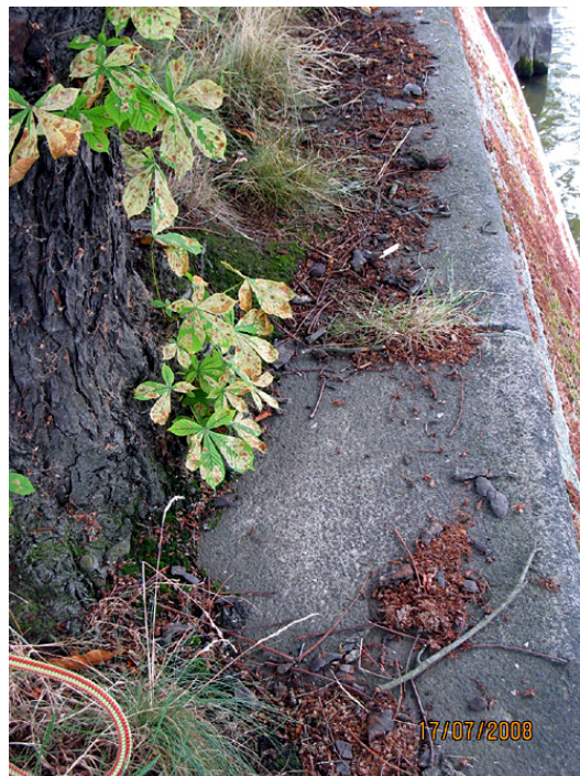
Abb.5: Enger Kontakt zwischen Stammfuß und Abdeckplatte.
