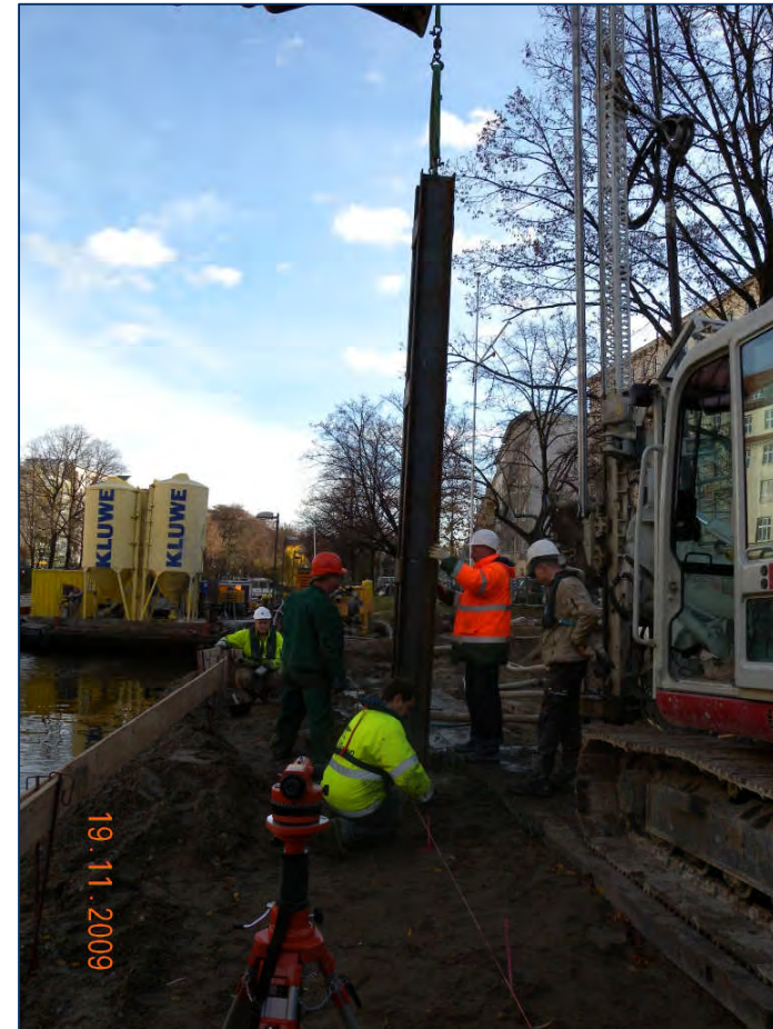
Einstellen des Trägers in die noch nicht abgebundene Säule
