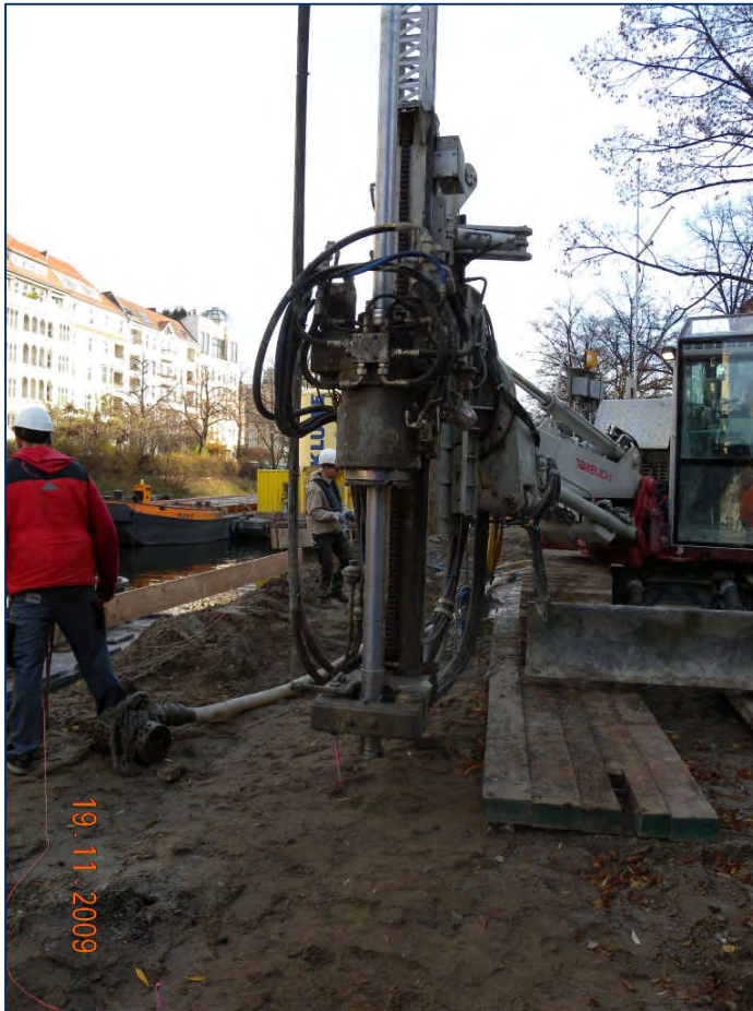
Herstellen der Säule
