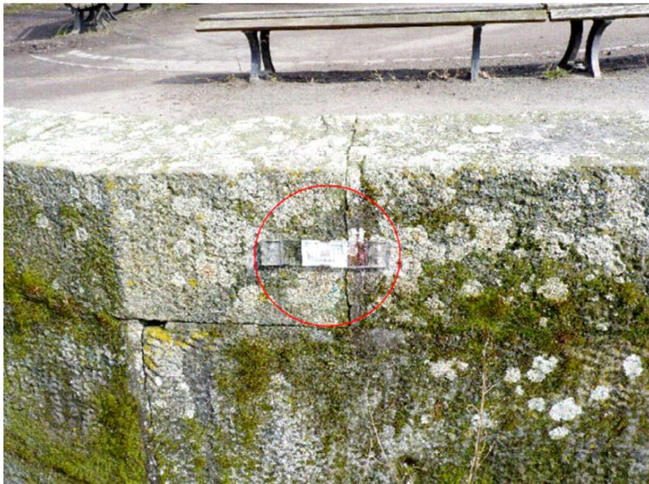
Abbildung 7: Rissmonitor B an Brüstung I /3/
